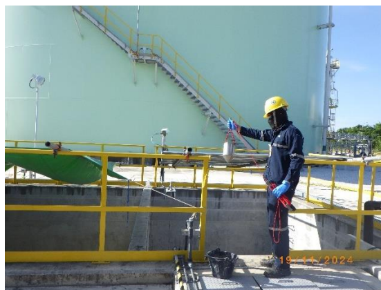
บ่อพักน้ำทิ้งภายหลังการบำบัดจากระบบแยกน้ำ-น้ำมัน ของโครงการ
